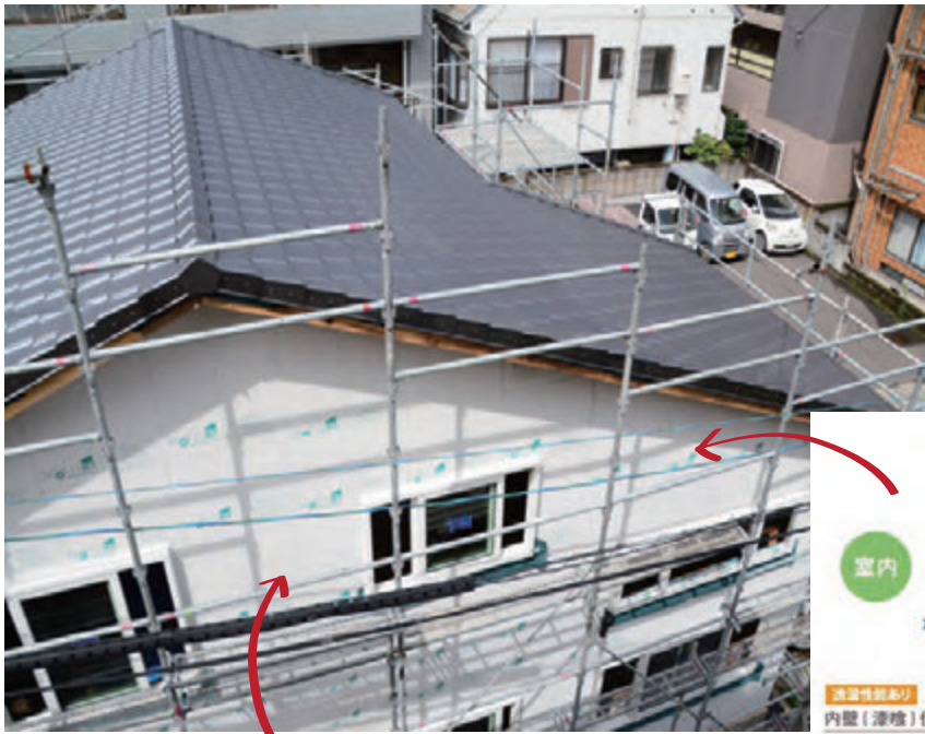
07 モイス、耐震用構造パネル
